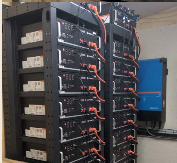
Netcongestie. Balans op het elektriciteitsnet door opslag in buurtaccu
