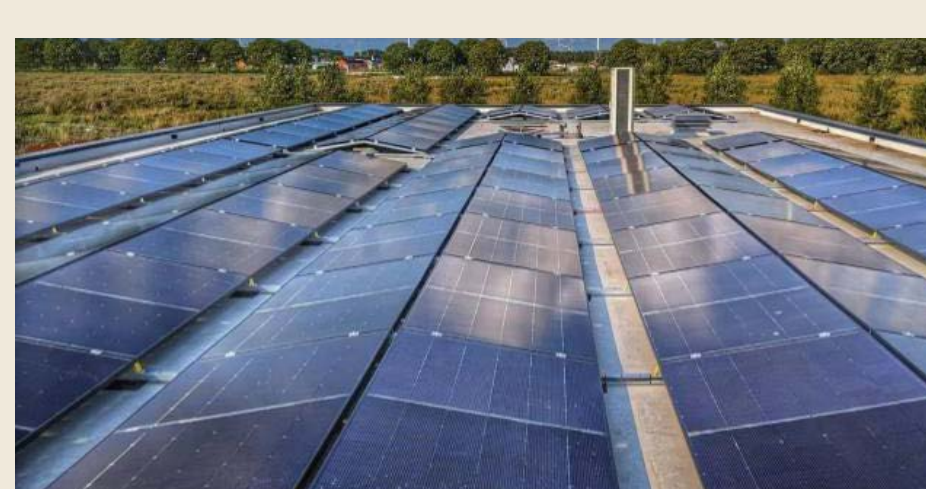
Duurzame opwek. Collectieve opwek en opslag van zonnestroom
